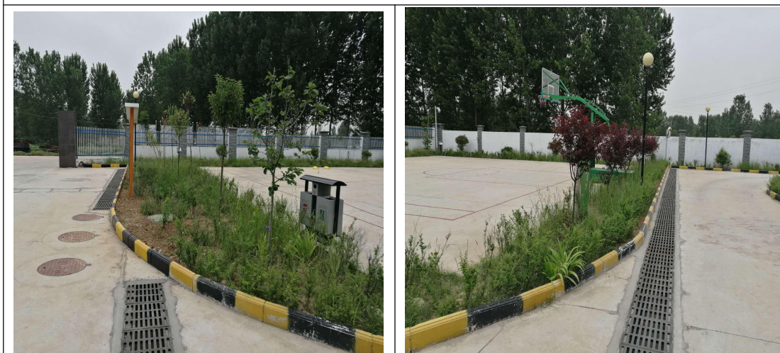
2018 年 10 月，升压站区排水措施布设情况
