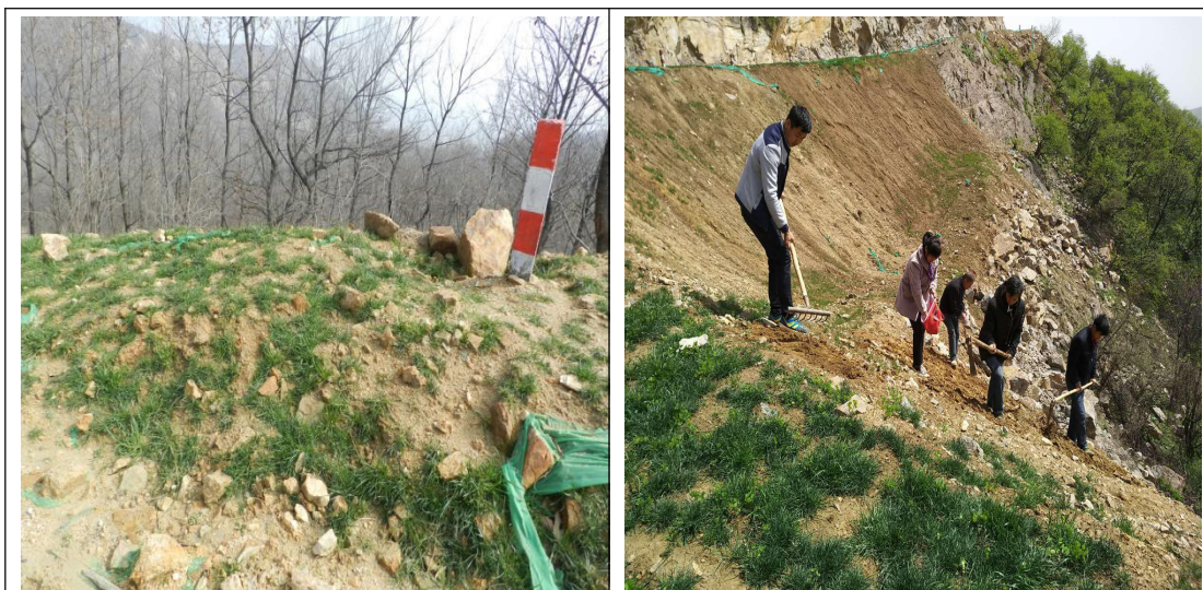
2018 年 8 月，道路边坡植物措施
