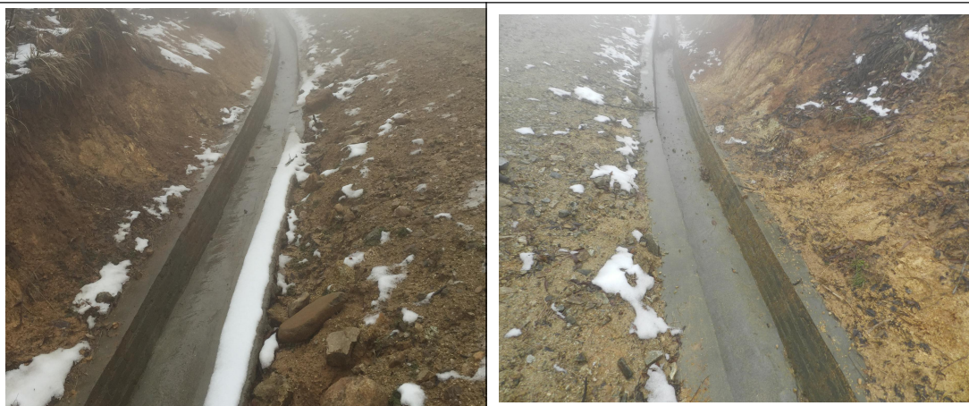
2018 年 2 月，道路区排水沟布设
