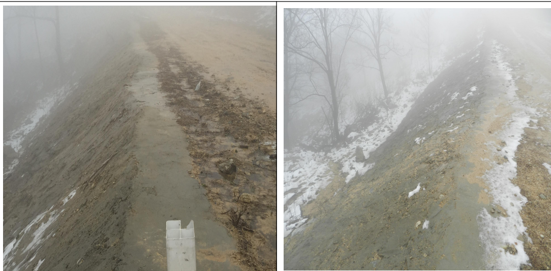
2018 年 1 月，道路区挡土墙布设。
