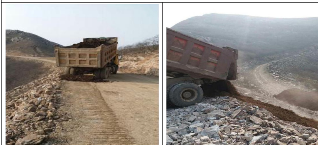
2018 年 8 月，道路区绿化覆土
