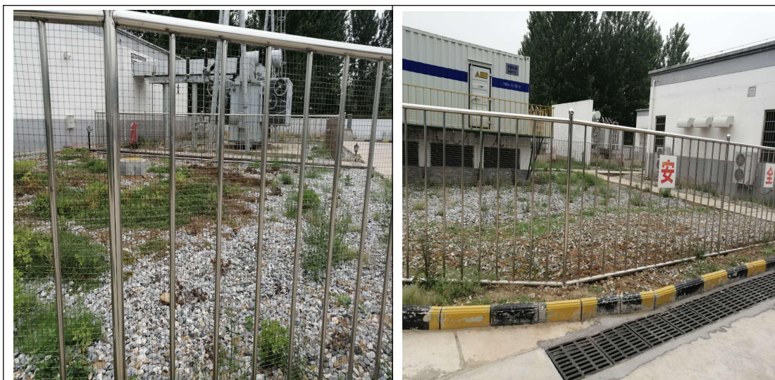
2018 年 10 月，升压站区碎石铺设。
