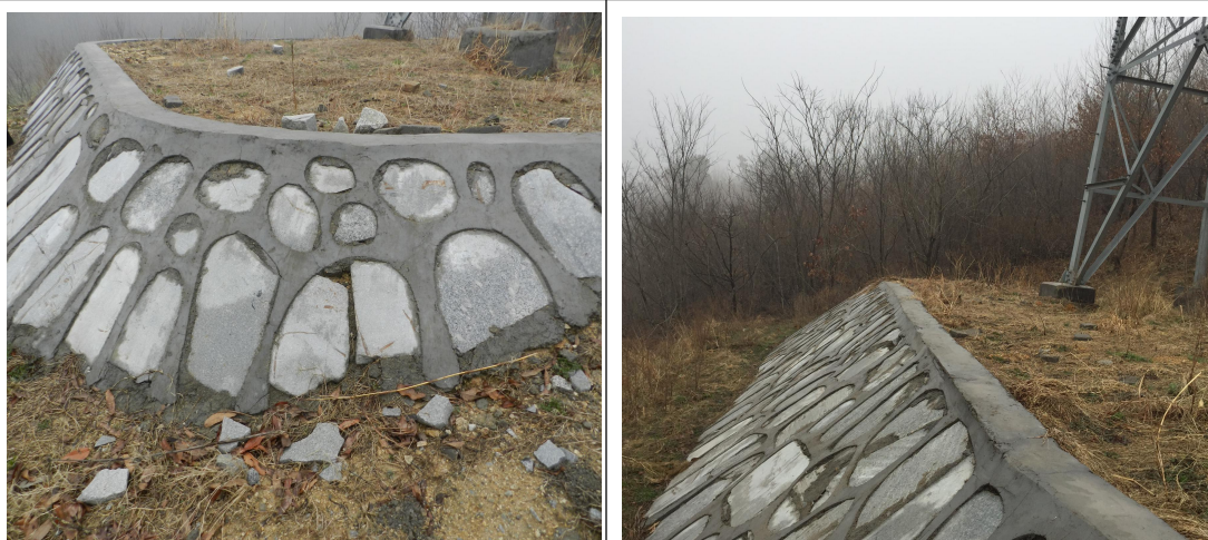
2018 年 3 月，集电线路区浆砌石护坡
