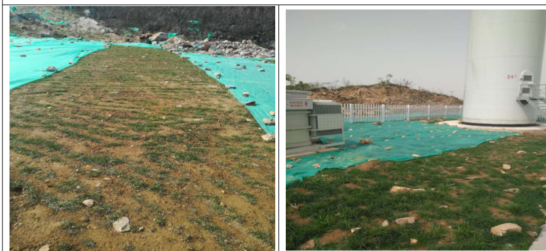
2018 年 8 月，风机及安装区绿化措施
