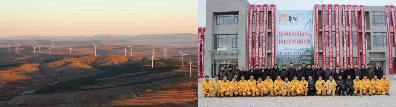
宁夏海原西华山30万千瓦风电项目是华润电力目前装机容量最大的风电项目，2016年12月23日顺利实现并网。至此，华润电力风电并网容量突破500万千瓦。
