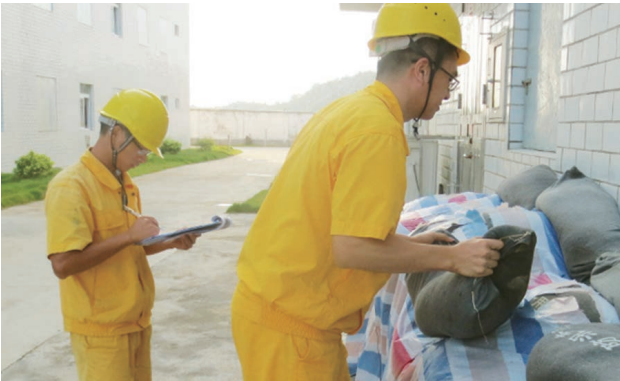
华南大区陆丰风电场陆丰3线电缆故障，经过10个多小时的昼夜抢修，在“莫兰蒂”台风登陆之前顺利修复故障。
