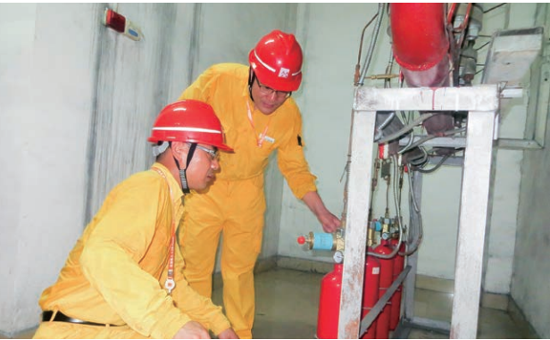
湖南华润电力鲤鱼江有限公司、华润电力湖南有限公司开展压力容器及压力管道专项隐患排查。
