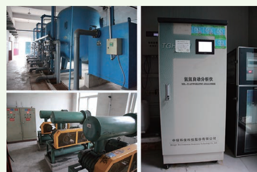
华润大宁生活污水站技改
