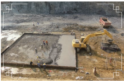
小黑江回龙山水电站基建现场
