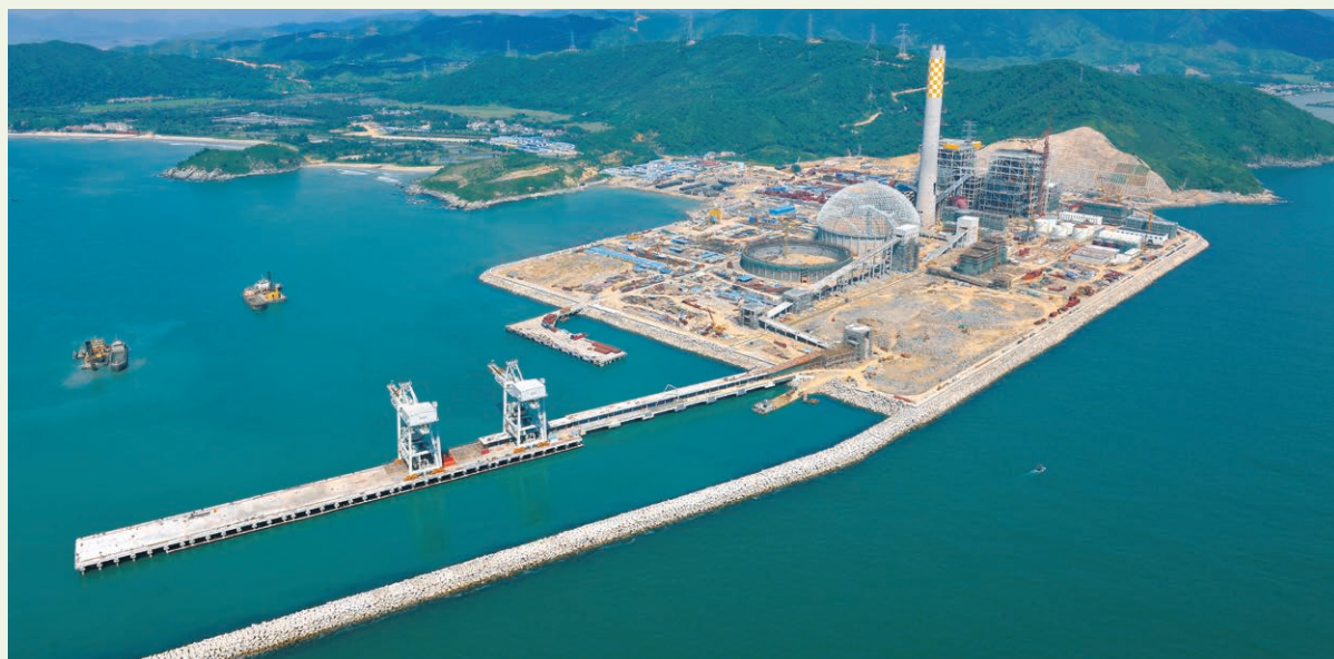
华润电力海丰电厂首台“超洁净排放”超超临界百万机组于2015年3月7日建成投产
