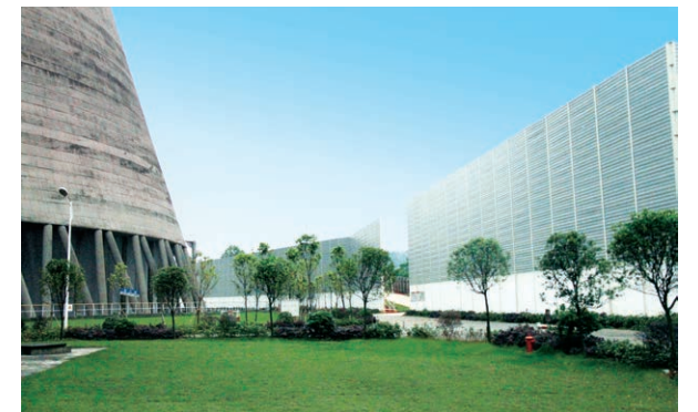
为防止凉水塔和厂内机器噪音影响周边居民生活，建设了消音墙
