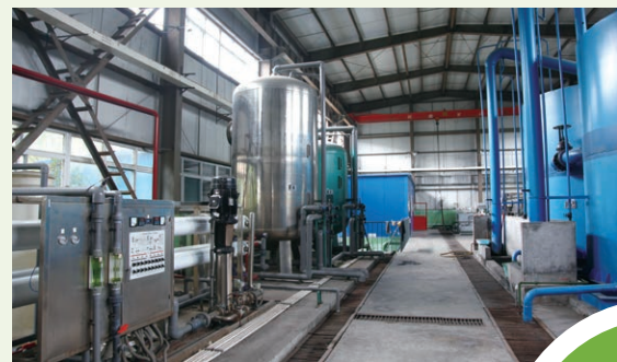
华润大宁矿区水处理系统
