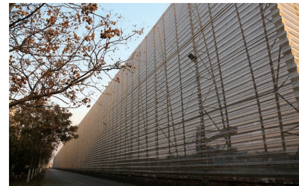
煤场防风抑尘网
