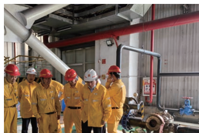
菏泽公司机组检修现场安全检查
