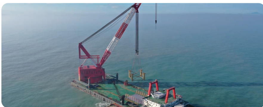
苍南1号基础施工定位平台作业
