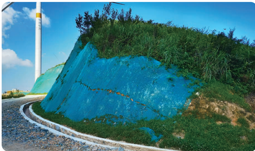
通过喷播草籽恢复风电场周边植被
